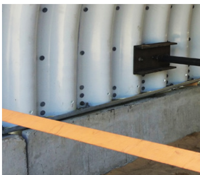
Fig. 8. Forbindelse mellem korrugeret stålbu og betonfundament
