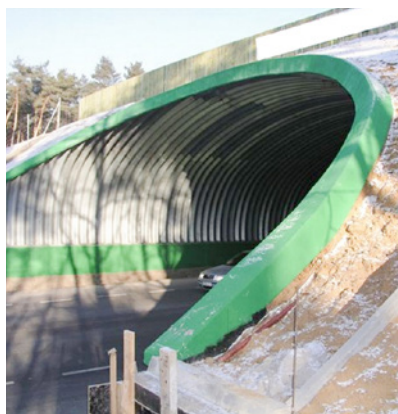
støttemur af beton – skrå ende
