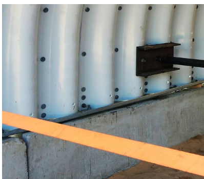
Fig. 8. Forbindelse mellem korrugeret stål bue og betonfundament
