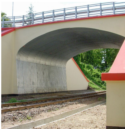
betonkrave – lige ende
